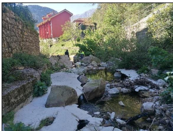
Las márgenes están flanqueadas por sendos colectores, envueltos en toda su longitud con una sección rectangular de hormigón de protección y cuya integridad queda en entredicho en numerosos tramos, consecuencia de la acusada erosión sufrida en su base de apoyo, presentando pérdidas puntuales con vertido al cauce que fomentan a su vez la vegetación aloctona. Estos colectores presentan fugas, que contaminan el cauce y los acuíferos por donde se sume el río.
