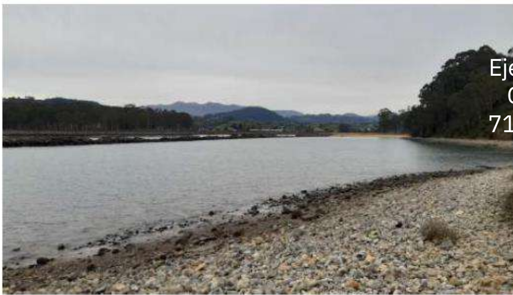
Fotografía 8. Vista interna del dique de la ensenada del arenal de Gemas del Mar.
