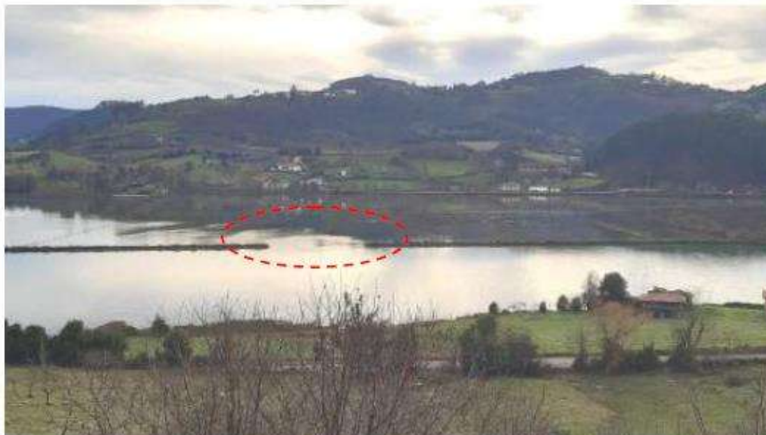
Fotografía 2. Punto de rotura del dique externo del porreo de la Marquesa.
