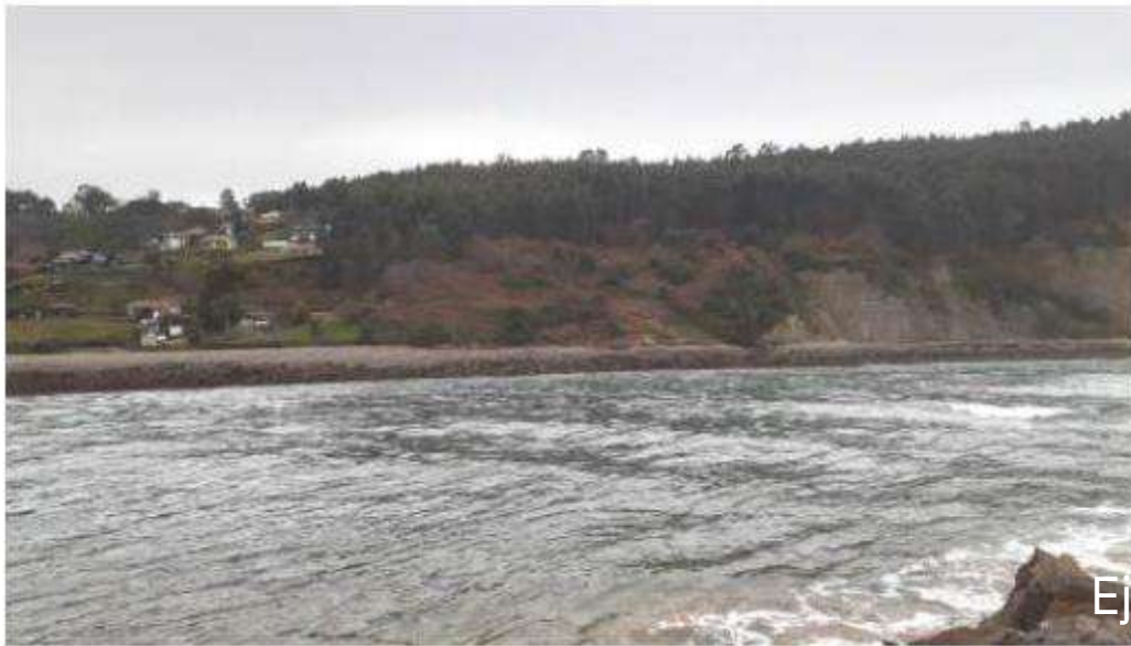
Fotografía 5. Vista externa del dique de la ensenada del arenal Gemas del Mar.
